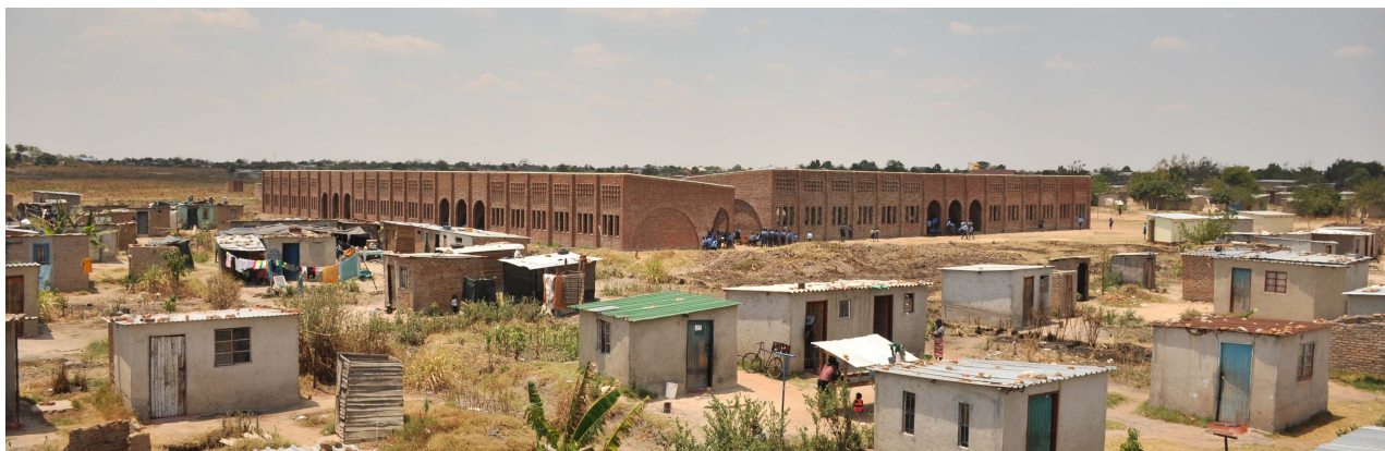
Abb. 2: 10 fertige Klassenräume nach Abschluss des 4. Bauabschnitts
