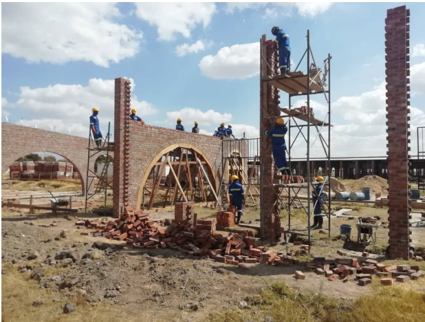
Abb. 7: Eckpfeiler und Bogenscheiben im Bau
