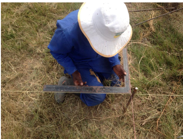
Abb. 3: Aufbau Schnurgerüst und Einmessen der Höhen
