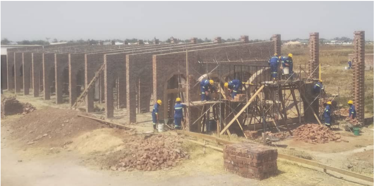
Abb. 14: Die Arbeiten an den 16 Bogenseiben, der Hauptkonstruktion, nähern sich dem Ende. Es folgen u.a. Boden- und Dacharbeiten, die noch ca. 3 Monate dauern werden.
