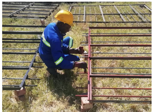
Abb. 10: Streichen der fertigen Fassadenrahmen
