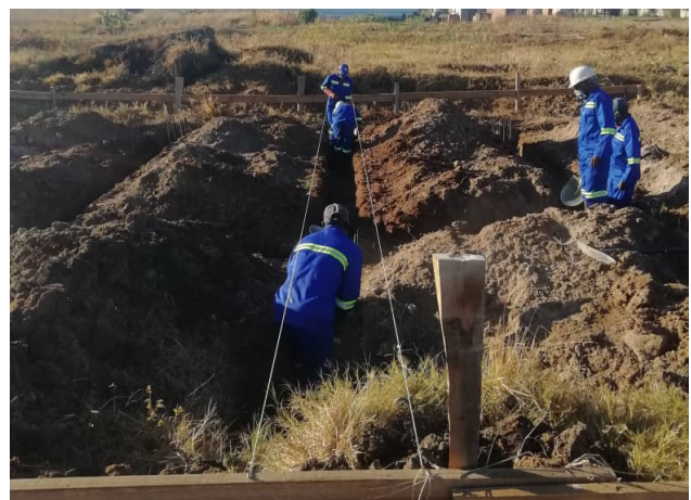
Abb. 4: Freilegen der Fundamente
