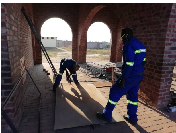
Abb. 9: Schweißen der Fassadenrahmen
