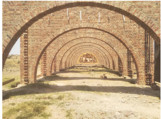
Abb. 8: Durchsicht durch die Bogenscheiben vor dem Bau der Klassenraum- Trennwände
