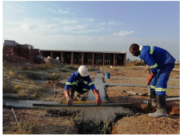
Abb. 6: Nivellieren und Abziehen der Oberkante Beton
